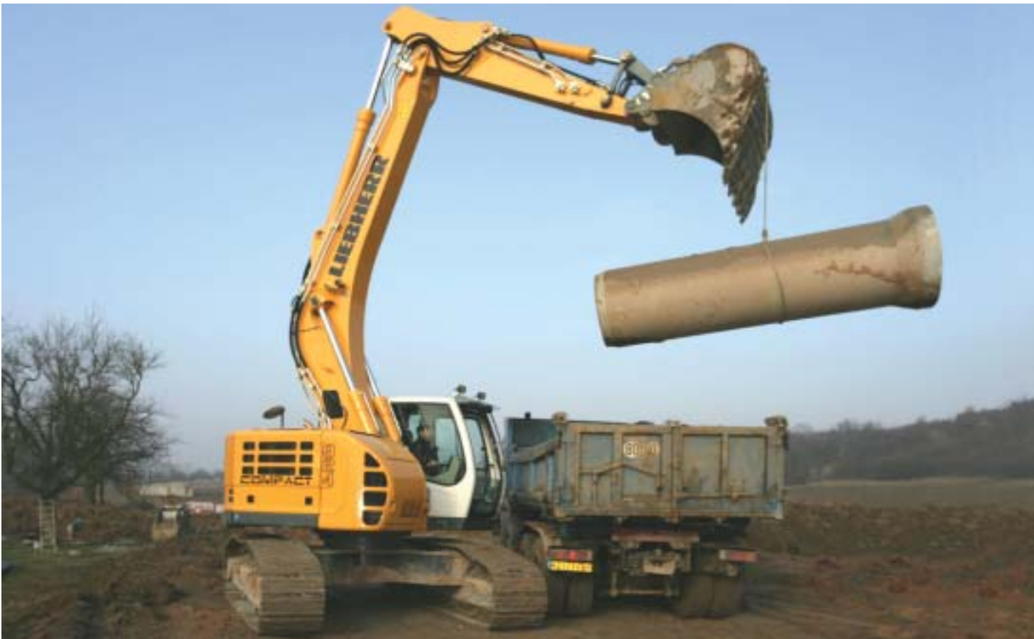
Liebherr-Bagger im Einsatz
